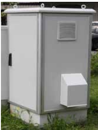
Bildet viser skap med ekstra luke nede for provisoriske kabler (ikke standard)
